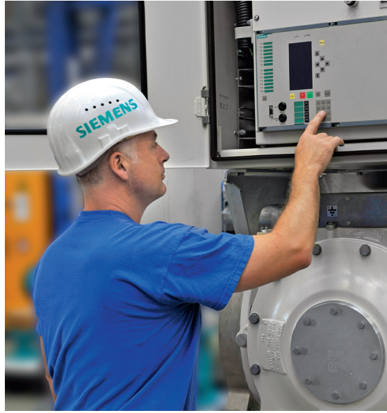
أنظمة التحكم بخلية القاطع الكهربائي في غرفة تحكم محلية ذات مقاييس مثلى
