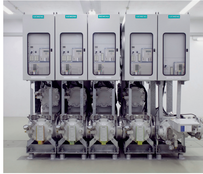
توفر سلسلة المنتجات 8DN8 درجة عالية من التنوع في شكل القواطع الكهربائية بفضل بنيتها القياسية
